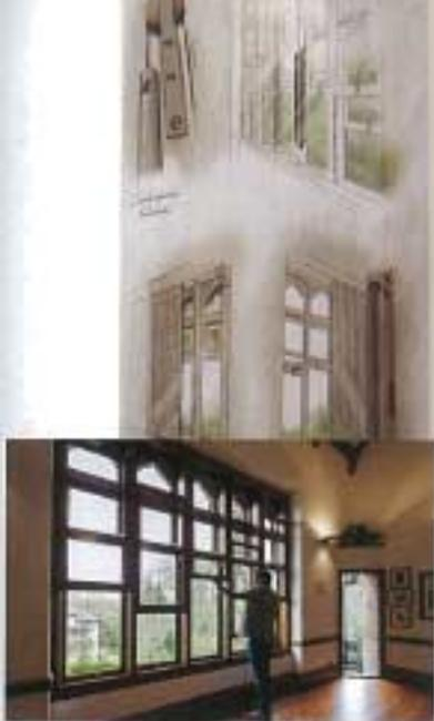
上・窓の開閉時に音が鳴る仕組みと、カーテン代わりの内扉が戸袋に納まる仕組みの解説図。
