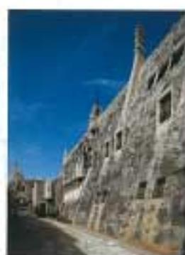
上・テラスの奥は小さな礼拝堂。下右・要塞のような外観だが、構造はレンガ造、外壁は石貼り。下左・鉄細工による銅の門。
